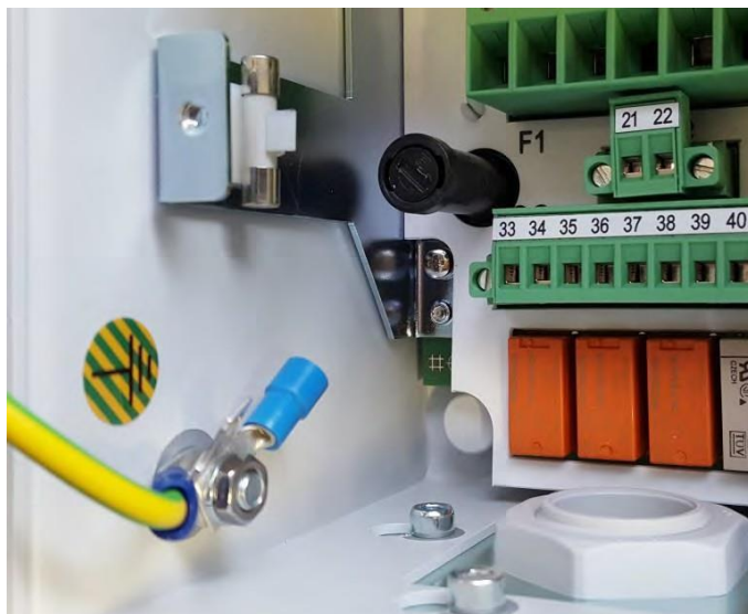
Подключение к заземлению регулятора REG-DA
