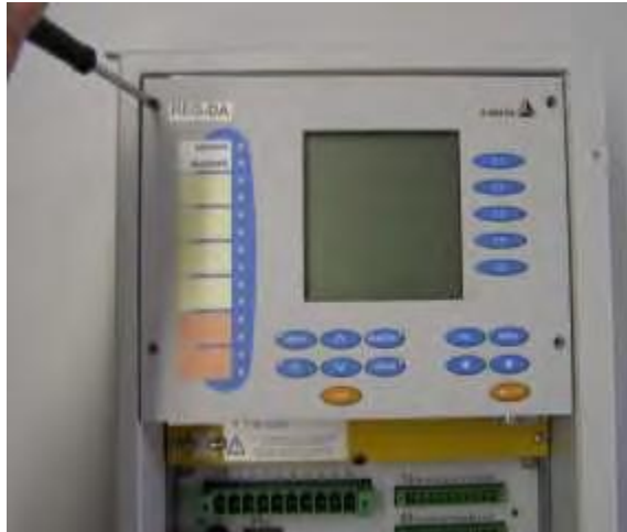
Отсоедините переднюю панель регулятора REG-DA
