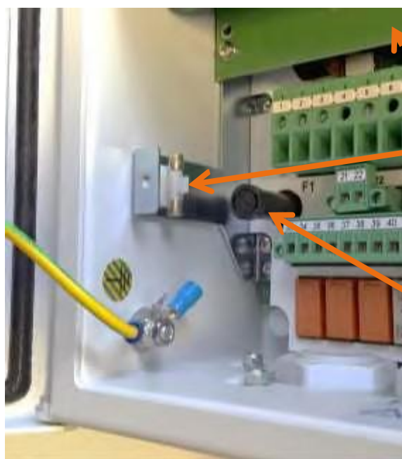
Держатель предохранителя и запасной предохранитель в регуляторе REG-DA
