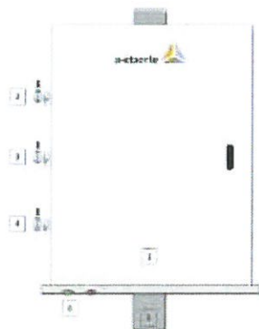
Montáž na sloup 7,5 kVA a 50 kVA
