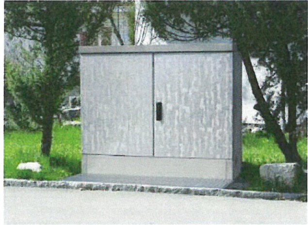
LVRSys™ v rozváděcí kabině z betonu
